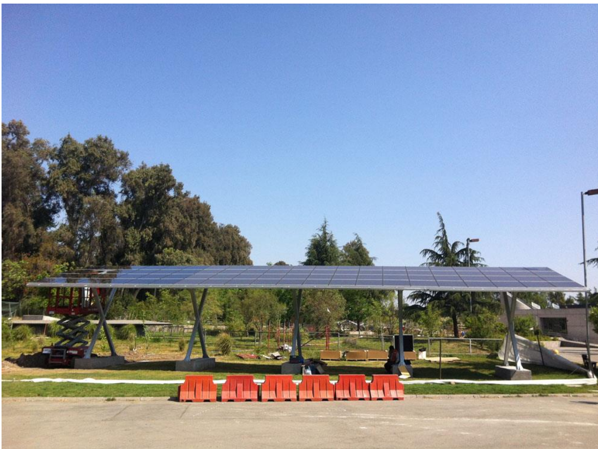
Ilustración 2-18: planta fotovoltaica de 10,5 [kW] del MIM con inyección sincronizada a la red, proyectada, construida y fotografiada en 2013 por el autor.
