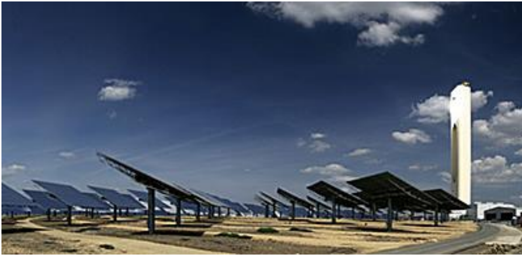
Ilustración 2-19: vista desde nivel suelo de central termosolar, gentileza de Abengoa Solar
