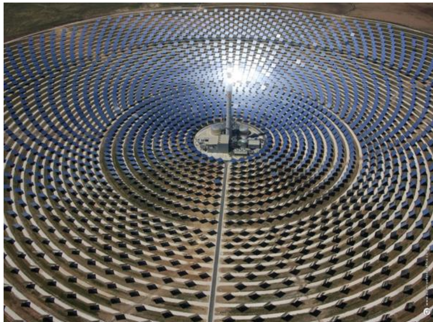
Ilustración 2-20: vista aérea de central termosolar, gentileza de Abengoa Solar
